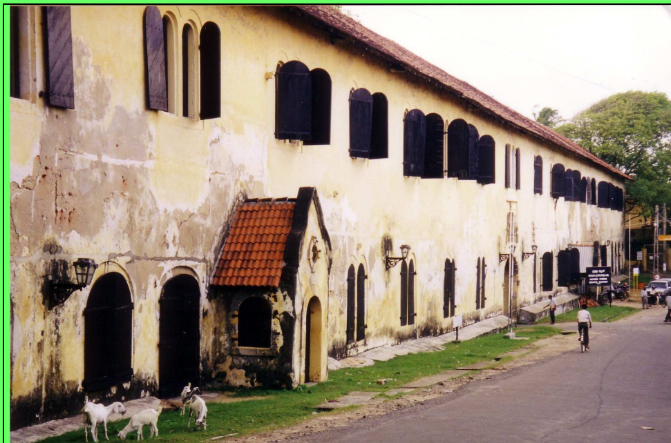
Afb. 5 V.O.C.- pakhuizen te Galle in 1999, foto DT
