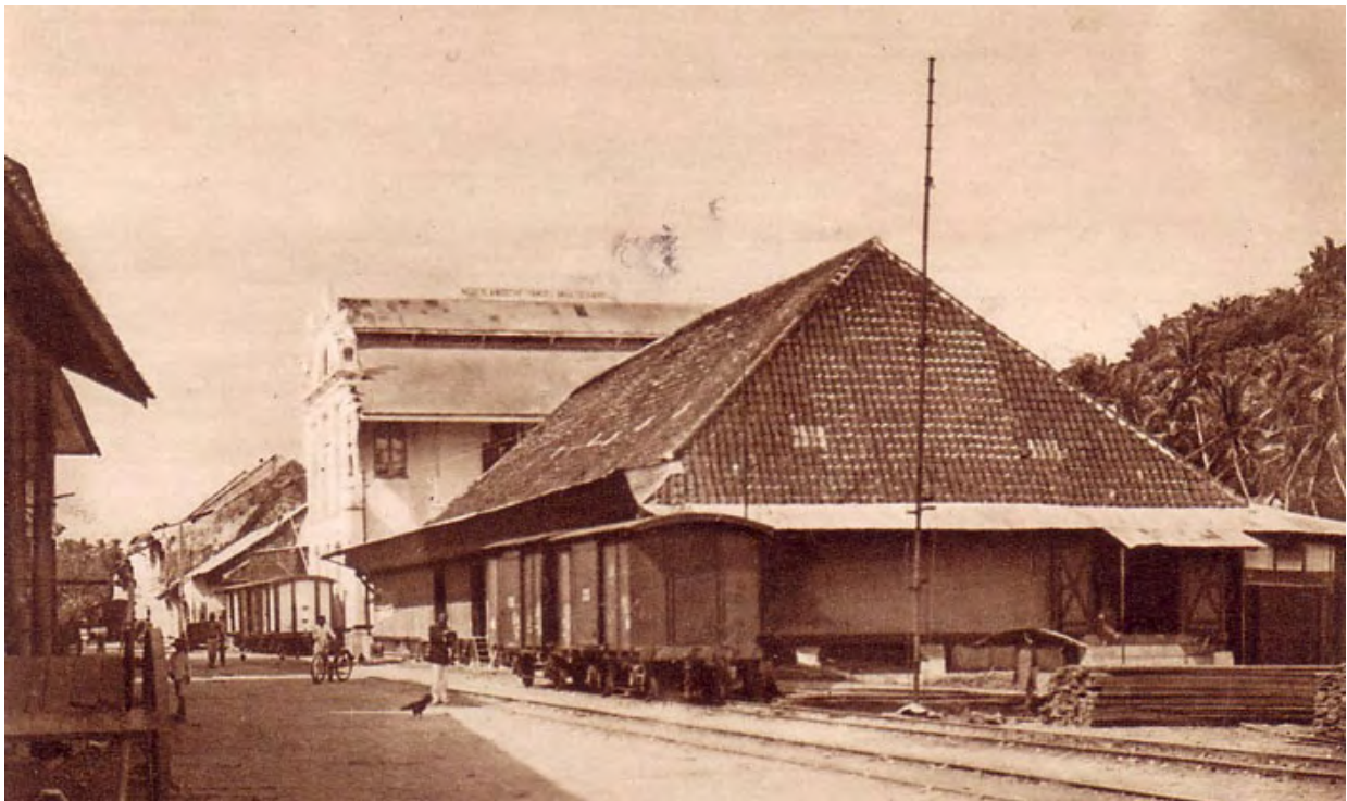
6. Deel van de handelskade, Padang 1910 Dit deel ligt in het verlengde van de Grevekade die op afbeelding 1 te zien is.
