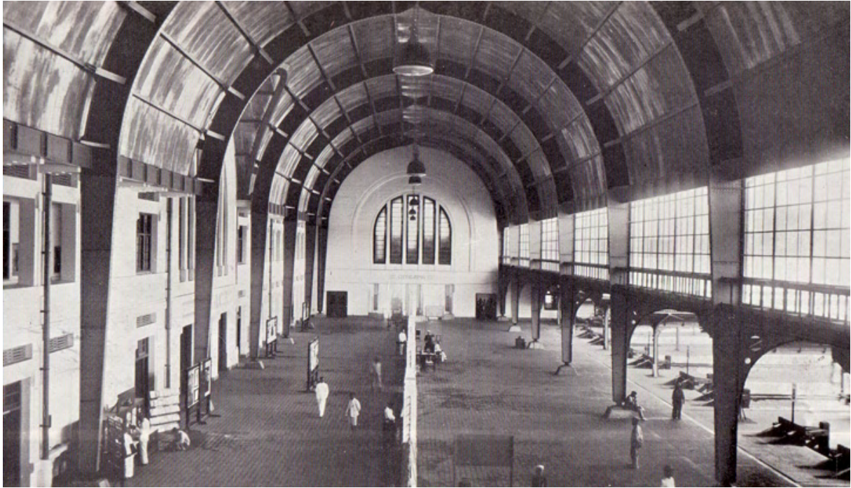
2. Station Batavia Benedenstad, Batavia 1937 De stationshal van noord (boven) naar zuid. De hal is ongewijzigd gebleven.
