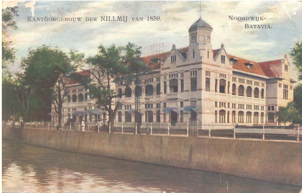
Afbeelding 1 Kantoor van de levensverzekerings- en lijfrentemaatschappij “NILLMIJ van 1859” in 1916 Het kantoor is gebouwd in 1914.
